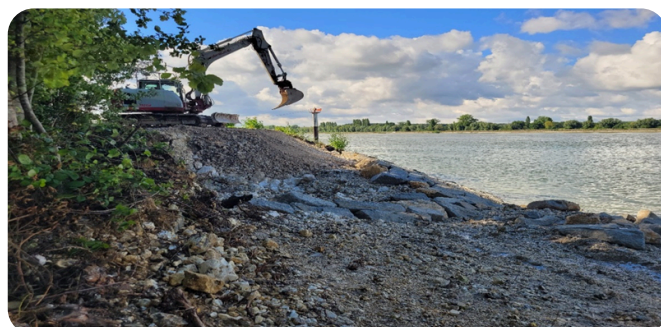
Mise en place d'enrochements
